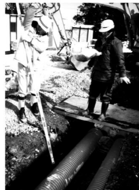
写6-2 土のう落下試験
