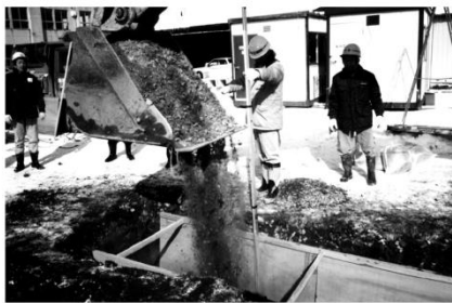
写6-1 砕石落下試験
