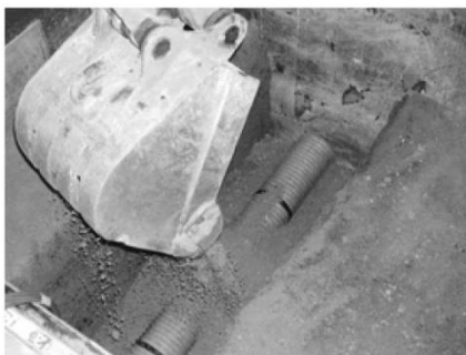
写8-4 供試管の埋戻し
