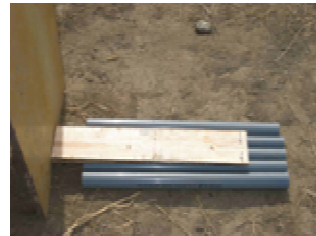
セパレータ移動防止治具及びダミーさや管とピン
