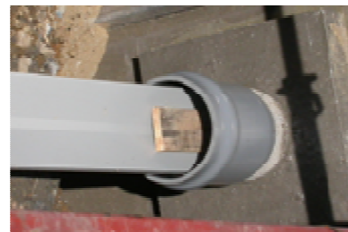
セパレータ移動防止治具を取付けた状態
