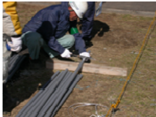
ダミーさや管切断作業
