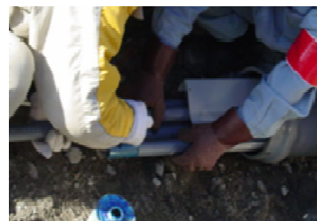
接着剤塗布作業
