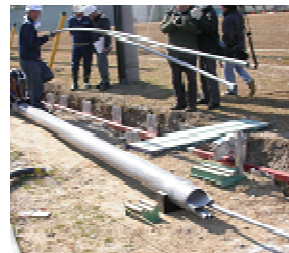
さや管の挿入
